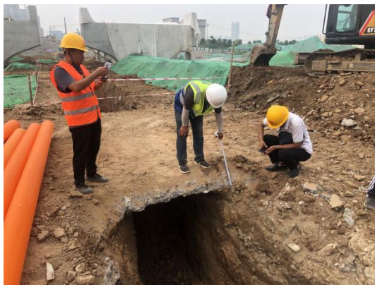
变更签证工程现场收方
