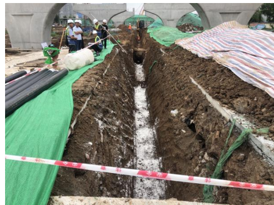
管线沟槽实测实量
