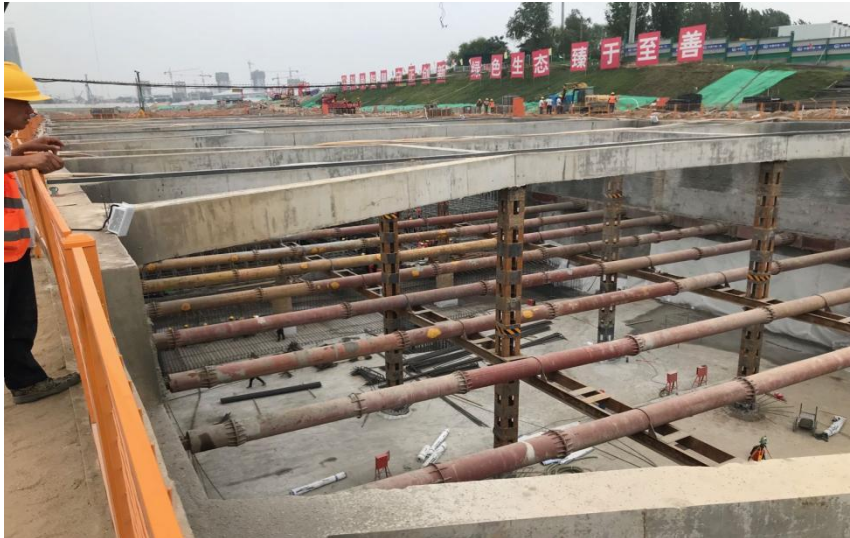
深基坑开挖及支护现场
