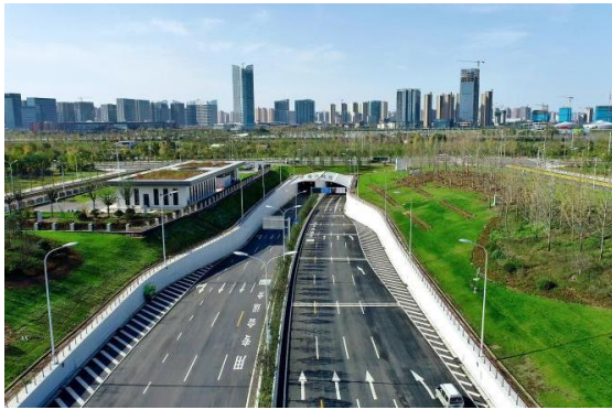
隧道东侧出入口
