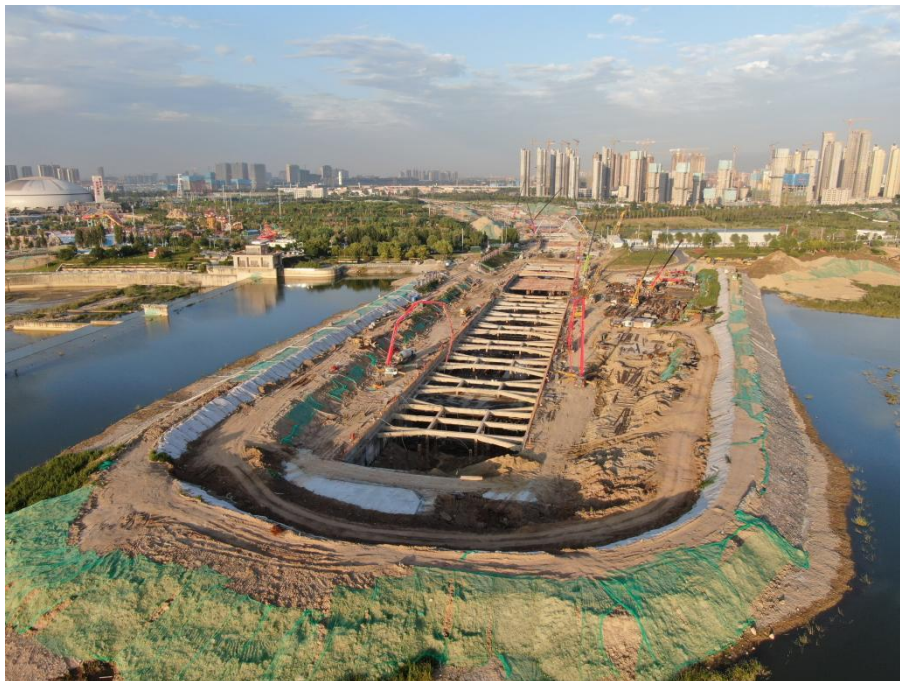
河道段围堰内施工现场
