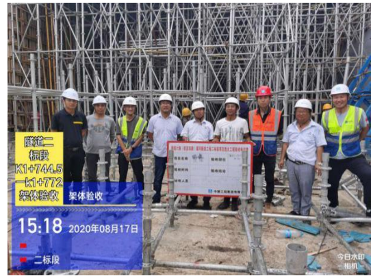
桥梁支架三方共检验收
