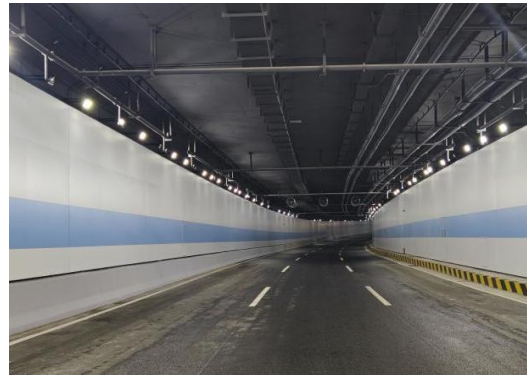
隧道内部实景
