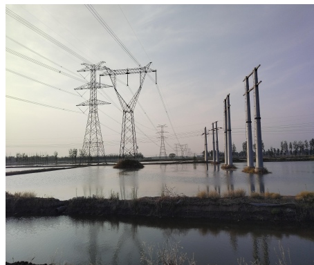
图 2.1-2 线路沿途跨（钻）越电力线路
